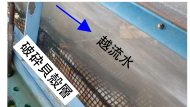
(b) 傾斜水路部
