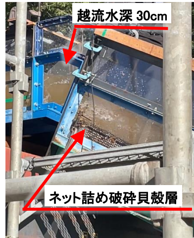
(a) 上部（法肩部）付近
