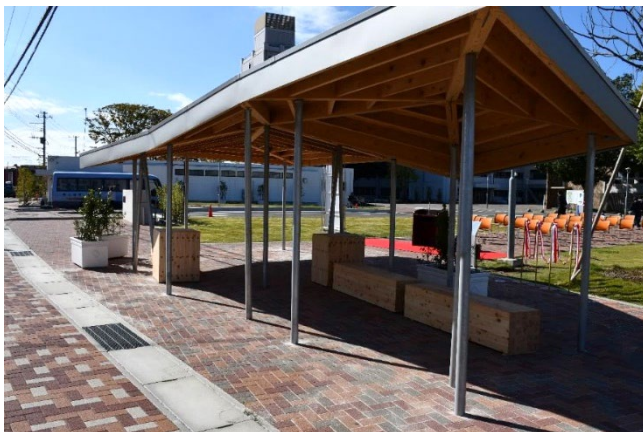
完成した休憩所「Connecting roof」
