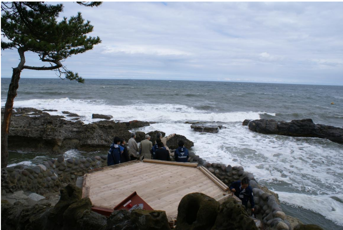
津波の被害を受け台座だけになった六角堂
